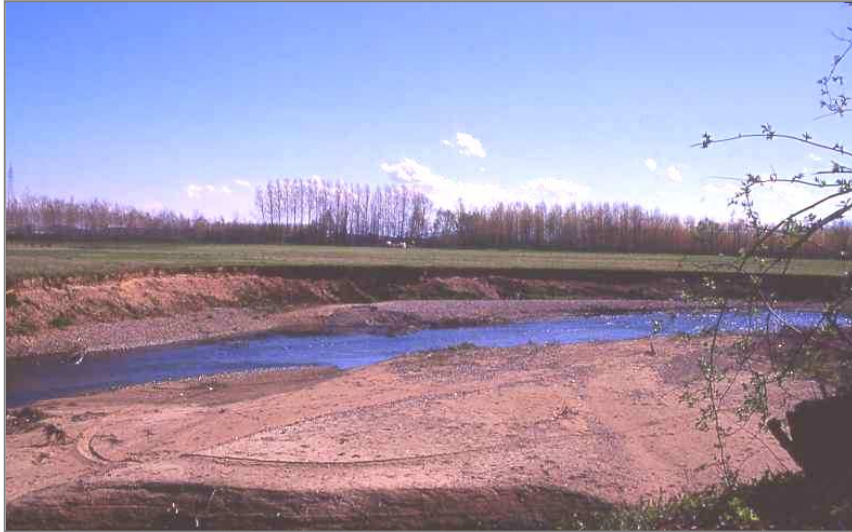
Alveo del Torrente Chisola
